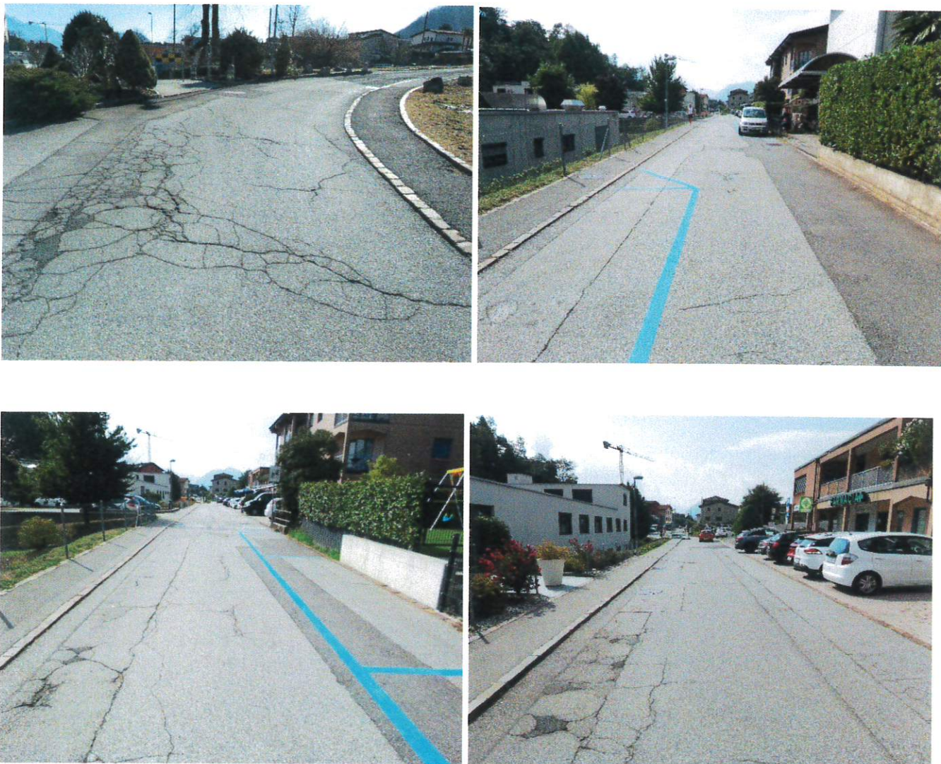
Esempi stato generale della pavimentazione
